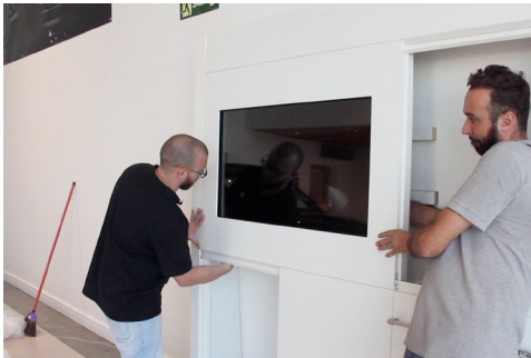
10 - Encaje el panel del televisor y ajuste la posición de manera que quede apoyado en el panel frontal.
