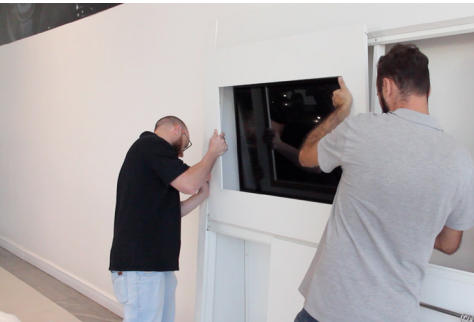
10 - Encaje el panel del televisor y ajuste la posición de manera que quede apoyado en el panel frontal.
