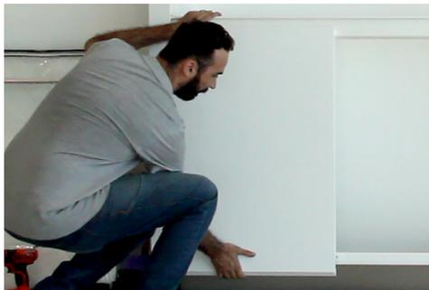
1 - Coloque as placas de madeira na estrutura metálica, encaixando-as de cima para baixo, seguindo a ordem conforme indicado abaixo:
