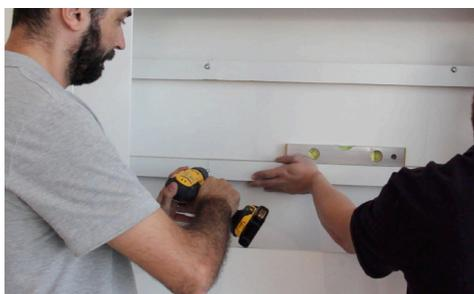
5 - Posicione o parafuso autobrocante no local e fure a parede, de maneira que as travessas de madeira fiquem fixadas nas colunas de metal por trás do Drywall.
