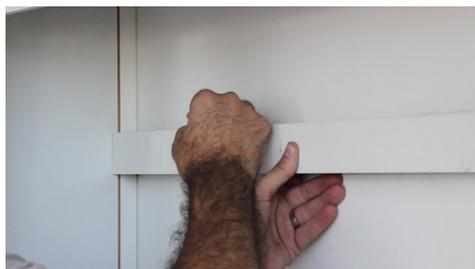
2 - Com o auxílio de um nível, posicione a travessa de madeira e marque os locais onde serão feitos os furos para fixação na parede e o local onde será fixado o suporte da TV de acordo com o gabarito.
