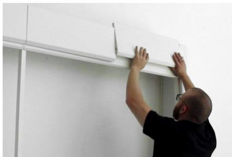
6 - Remova os parafusos que prendem as testeiras umas às outras. Empurre-as para cima para removê-las do painel.
