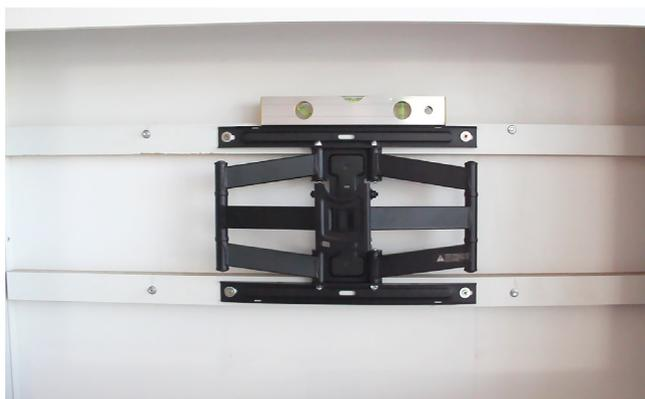
9 - Posicione o suporte e fixe-o utilizando os parafusos e arruelas enviadas.
