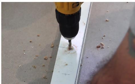
3 - Fure as travessas nas marcações onde serão colocados os parafusos autobrocantes nas travessas de metal da parede.
