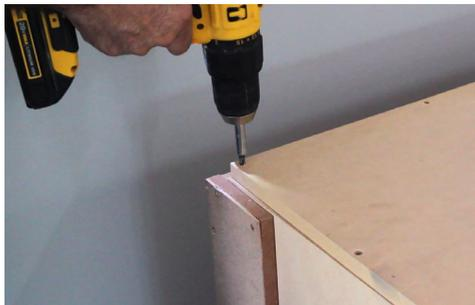
1 - Desparafuse os parafusos da tampa da caixa.
